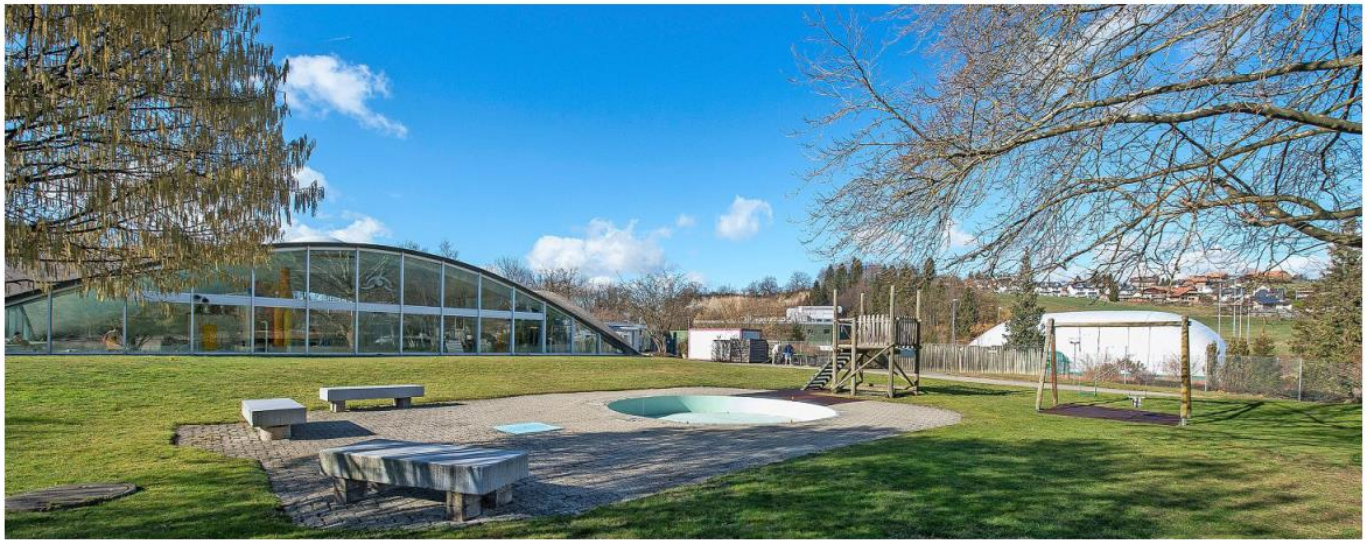
Wie das Sportzentrum Heimberg in Zukunft aussehen wird, ist derzeit ungewisser denn je. Die Absage der Stadt gefährdet das ganze Ausbauprojekt. Foto: Patric Spahni
