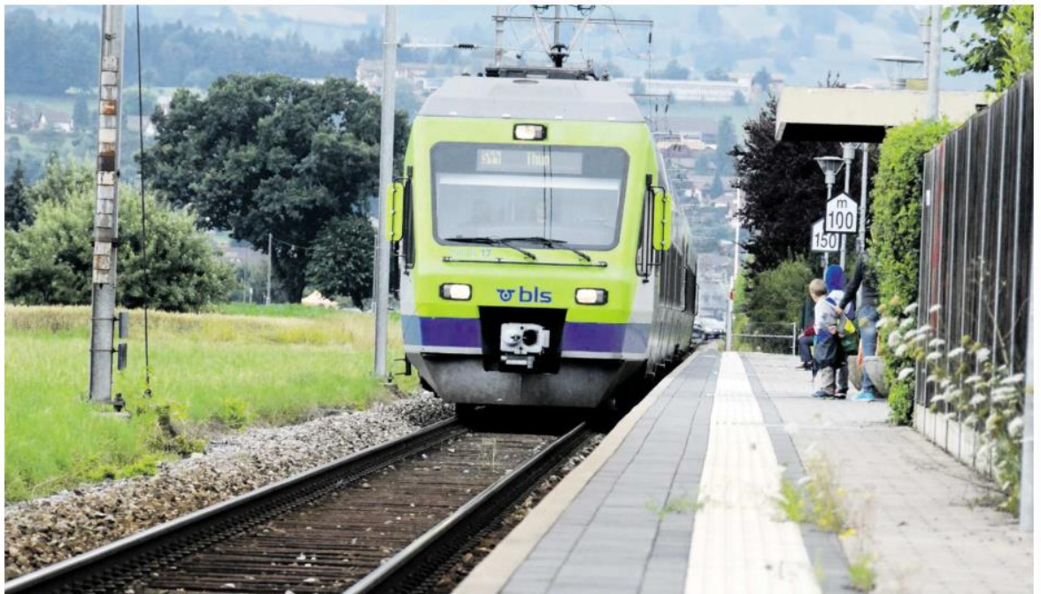
Die Haltestelle Uetendorf Allmend: Auch hier möchte die BLS das Gleis auf zwei Spuren ausbauen. Foto: Marc Imboden
