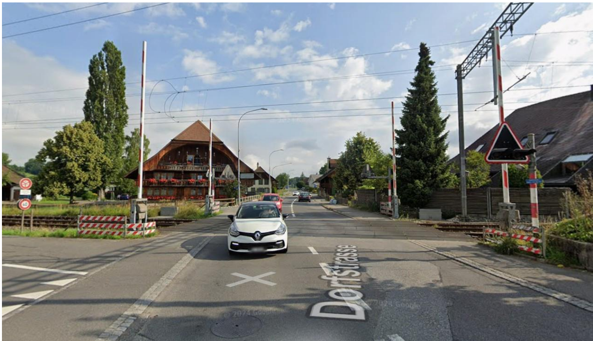
Der Bahnübergang Dorfstrasse in Uetendorf muss saniert werden.
