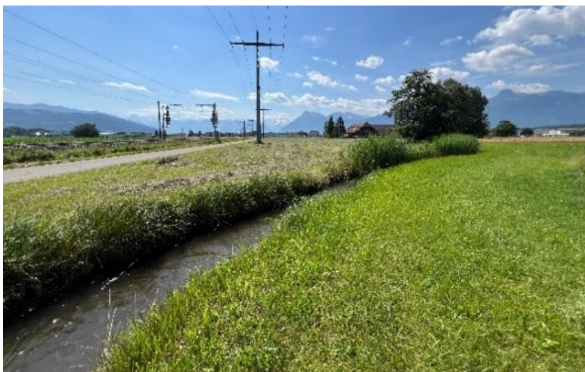
Abbildung 12 Glütschbach heute, Abschnitt km 2.454 - km 2.600, gegen Fließrichtung. Aufnahme vom 28.06.2024, IMPULS AG.
