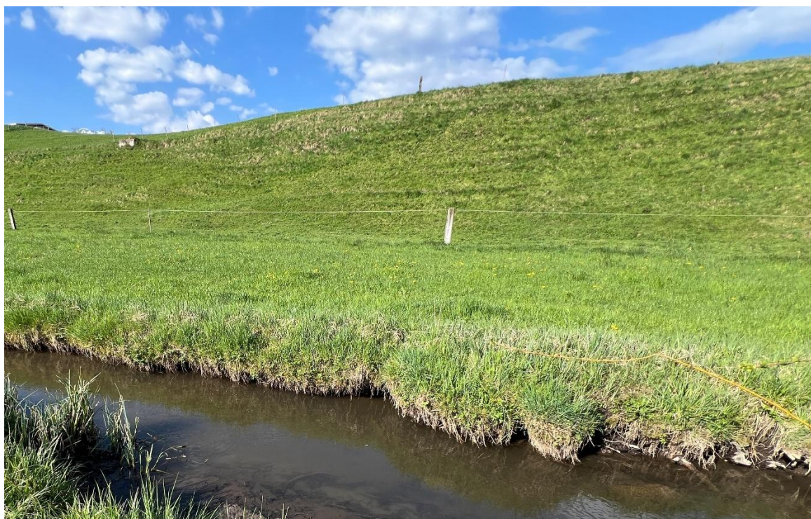
Abbildung 15: Erosion an der Hangrippe, wo Gefahrenhinweise für Rutschungen ausgeschieden sind. IMPULS AG
