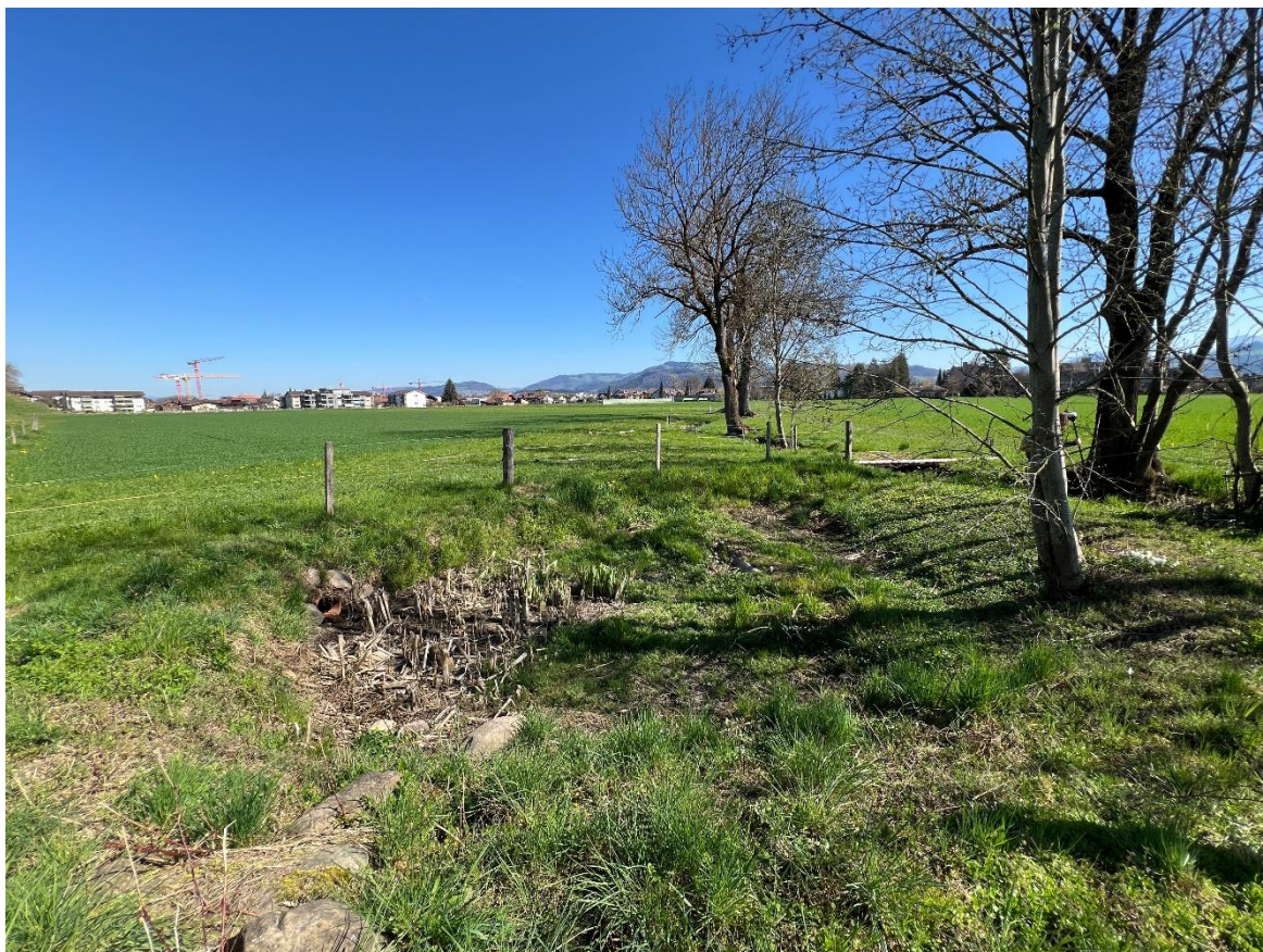
Abbildung 18: Das ausgetrocknete Retentionsbecken bei km 4.769. Aufnahme vom 04.04.2025, IMPULS AG.
