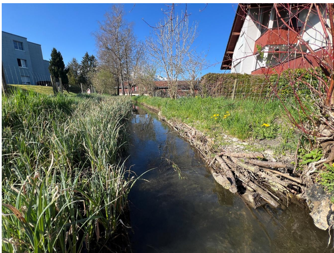
Abbildung 16 Verlandetes Ufer mit Schilffinewuchs sowie Ufersicherung aus Faschinen. Glütschbach heute, Abschnitt km 4.260 - km 4.495, gegen Fliessrichtung. Aufnahme vom 04.04.2025, IMPULS AG.
