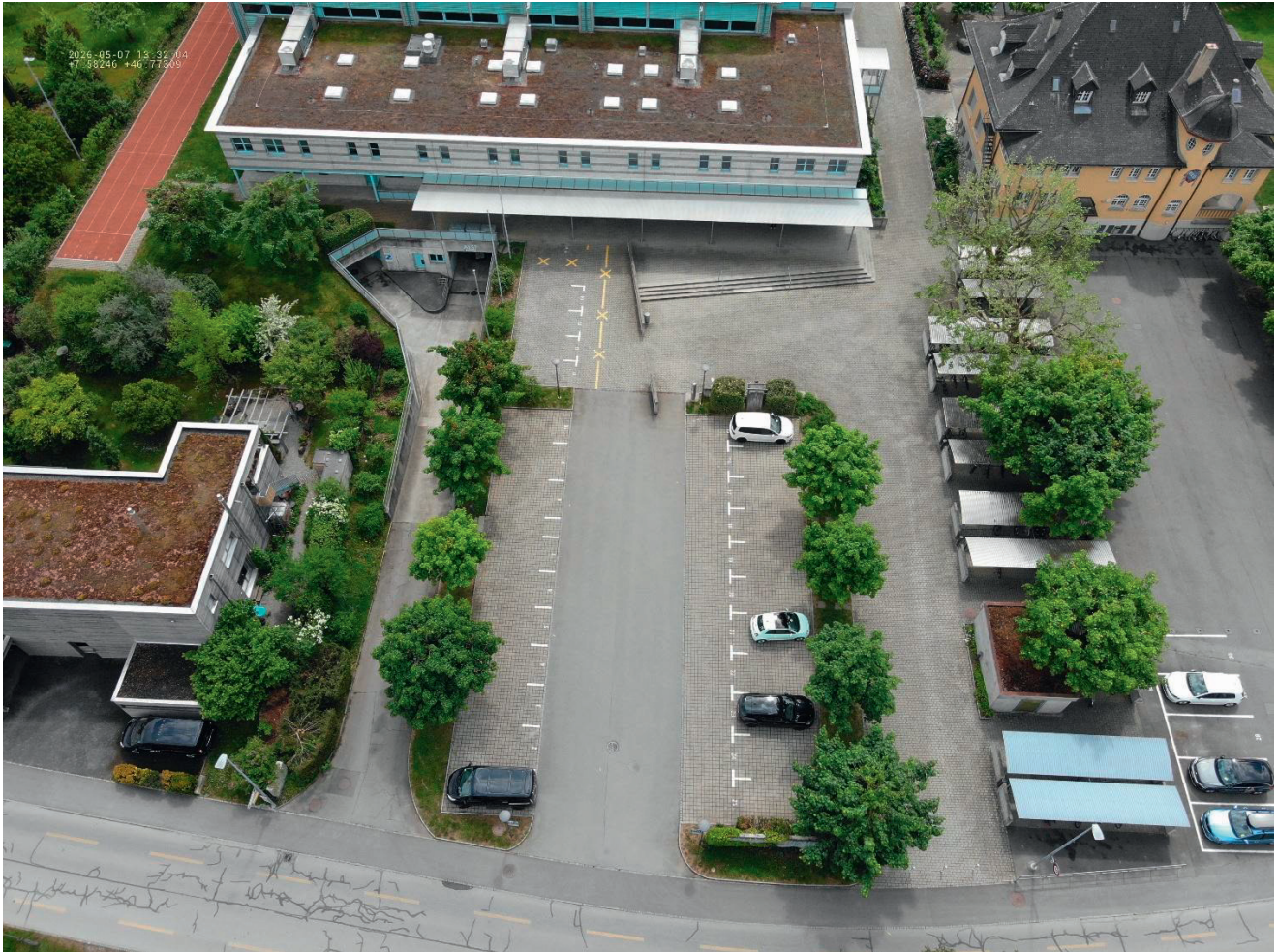
Standort Schulcontainerprovisorium Schulhaus Bach
