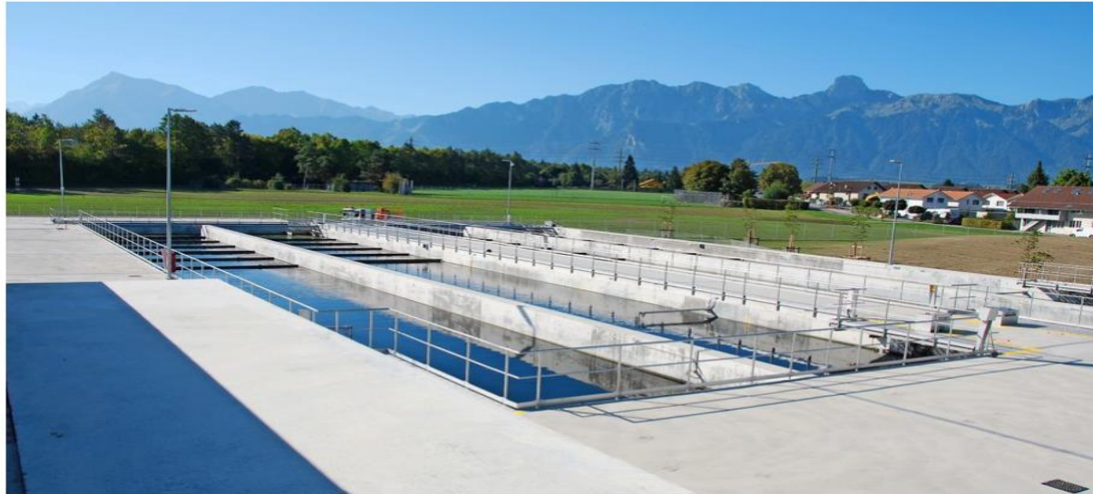
Die Absetzung der neuen Reinigungsstufe der ARA Thunersee. Hier sinkt die mit Schadstoffen vollgesogene Aktivkohle auf den Grund ab und wird danach mit dem Klärschlamm der Verbrennung zugeführt.
