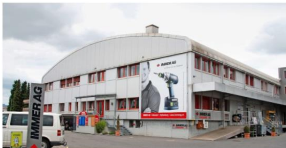
Die Lagerhalle der Immer AG in Utendorf: Im obersten Stockwerk möchte Gym Berner Oberland eine Trainingshalle einrichten und betreiben.
