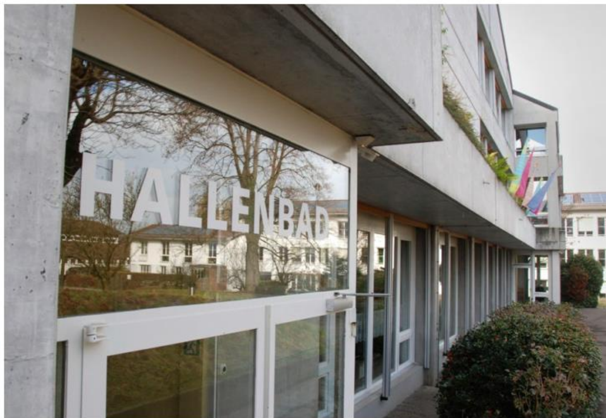
Fällt dem Rotstift nun doch nicht zum Opfer: Das 1975 erbaute Hallenbad Riedern.
