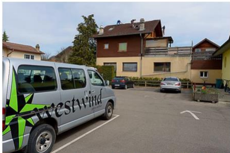
Am Tag nach dem Brand: Beim Gebäude des Wohnheims «Westwind» an der Jungfraustrasse in Uetendorf laufen Aufräumarbeiten. Foto: Patric Spahni
