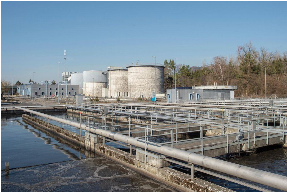
Über den Klärbecken der ARA Uetendorf könnten schon bald Solarpanels entfaltet werden. Foto: Franziska Rothenbühler
