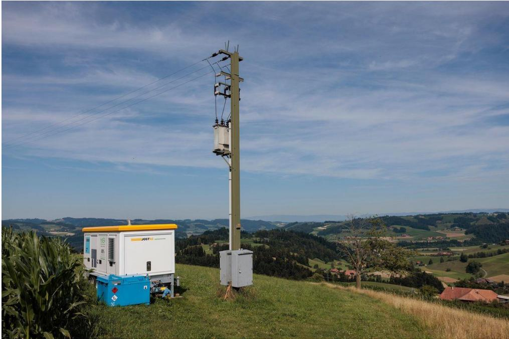
Weisser Kasten, gelber Deckel, spannender Inhalt: Das hybride Notstromaggregat wird in der Nähe von Emmenmatt getestet.
