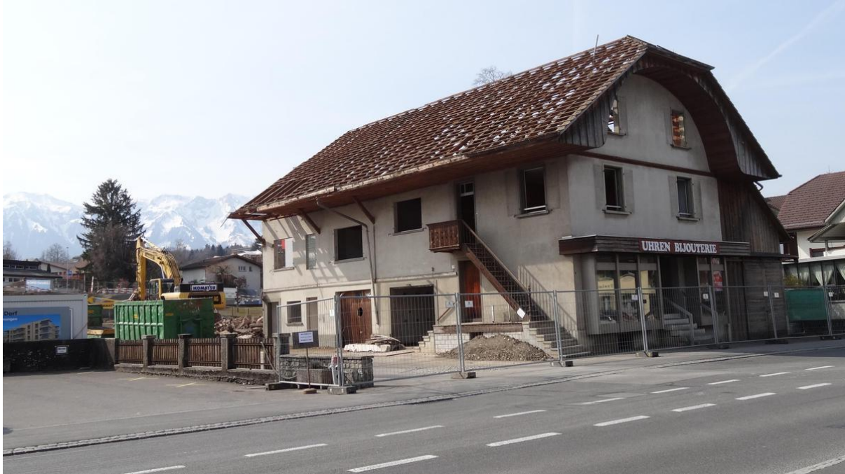
Das «Uhremacherhuus» an der Dorfstrasse 27 wird abgerissen.
