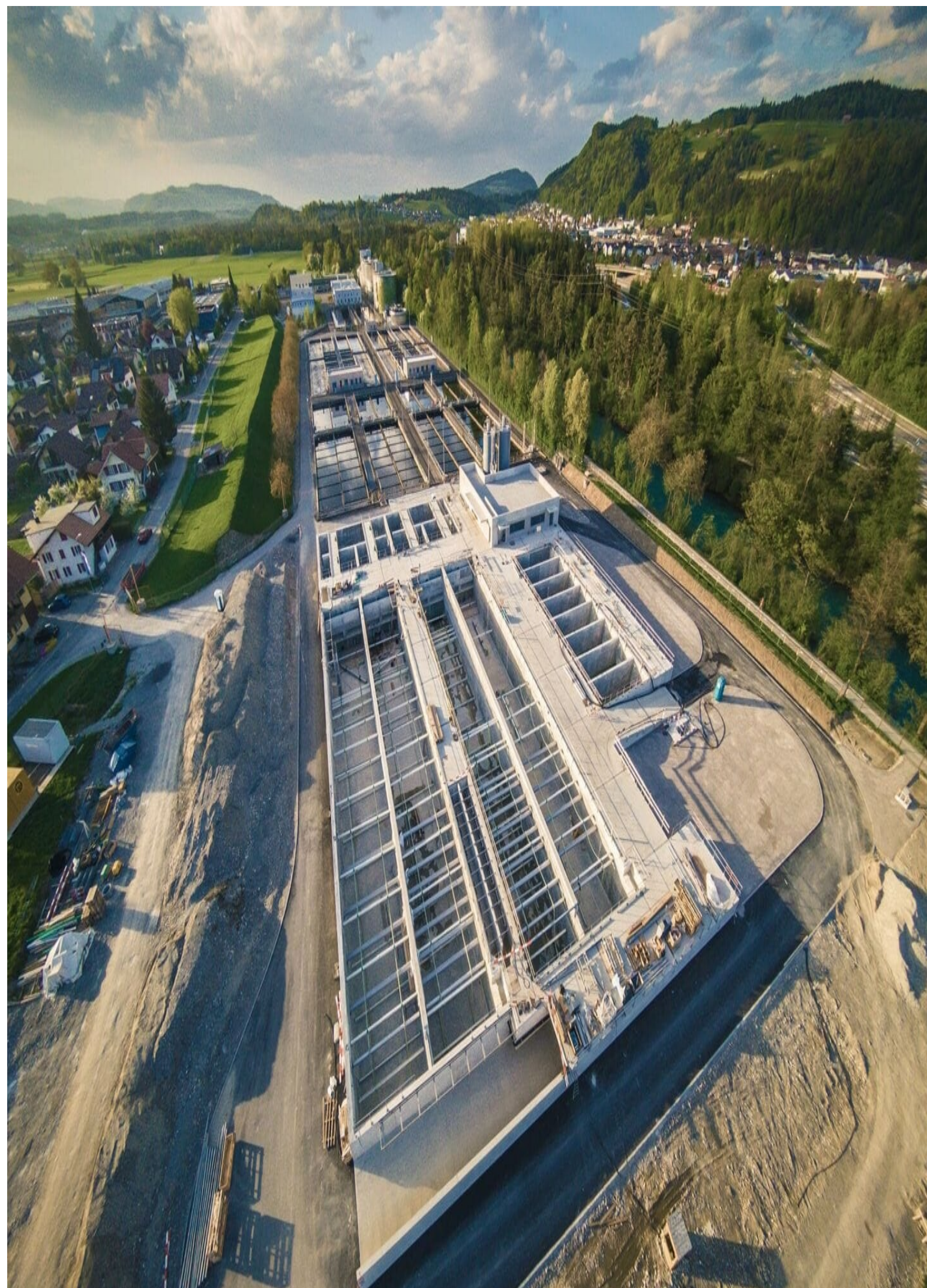
Neue Pulveraktikohlen-Anlage kurz vor der Fertigstellung 2018
