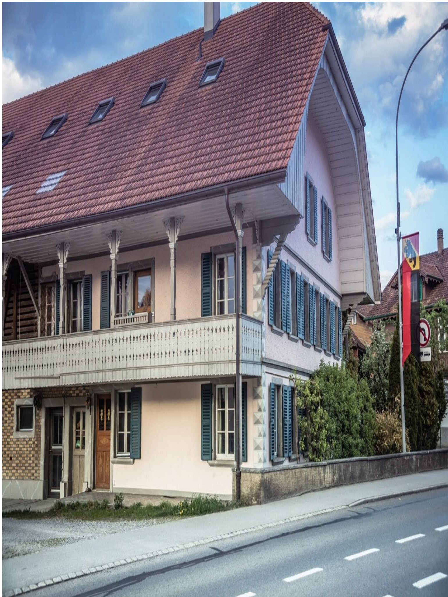
Das Ofenhaus, erbaut um 1820 (genannt Barock- Stöckli), ist ein eleganter Bau mit Mansarddach, einer Frontlaube mit Ausschnitten und Karnies-Einfassungen an der Dachkante. Zusammen mit dem Eichberg und Wildenrüti ist es eines der wenigen erhaltenen Ofenhäuser in der Gemeinde.
