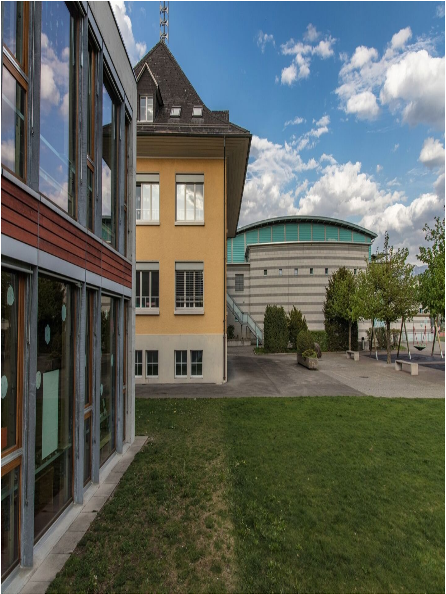
Östlich des Bachschulhauses hat die Einwohnergemeinde 1993 eine Mehrzweckhalle mit Aussenanlage realisiert. Die Dreifachhalle mit Bühnen- und Nebentrakt ist ein Beispiel zeitgenössischer Architektur. Auffallend sind die elegante, gerundete Dachform und die mit türkisfarbenen Wellplatten verkleideten Fassaden. Hier finden auch die Gemeindeversammlungen und andere Veranstaltungen statt.
