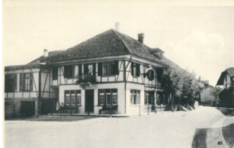
Auf den nachfolgenden Bildern kann man erkennen, dass das Rössli umgebaut wurde. Der Gasthof und dessen verschiedene Stuben wurden auf versetzten Ebenen gebaut. Deshalb sieht man auf dem älteren Bild noch die Seitentreppe. Das Rössli wurde mit H-Trägern angehoben. Dank des guten Grundgerüsts des Riegbaus konnte dies ohne grosse Probleme umgesetzt werden. Teile des alten Gutshofs, wie die alte Holzwand beim Stammtisch sind immer noch Original.
