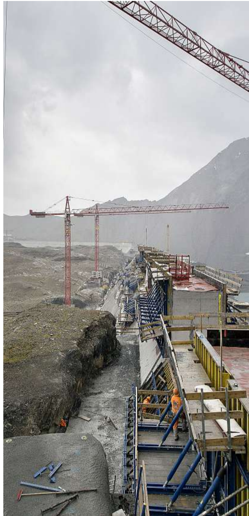
Falsche Strategie bei Stromversorgung? Grossbaustelle des Pumpspeicherkraftwerk
