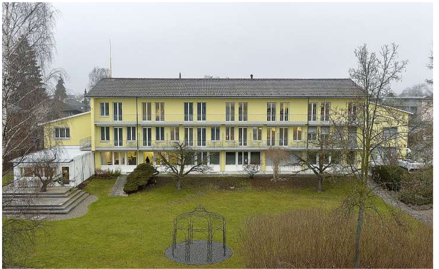
Das Profil der geplanten Mobilfunkanlage ist auf dem Dach der Klinik Hohmad bereits zu sehen (hier links im Bild). Gegen das Vorhaben der Swisscom sind nun über 200 Unterschriften eingegangen. Patric Spahni
