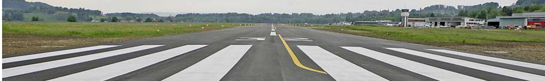
Die Piste 32 beim Flughafen Bern-Belp: Hier werden jene Maschinen landen, die ab 2015 über die neu geplante Südroute nach Belp gelangen.
