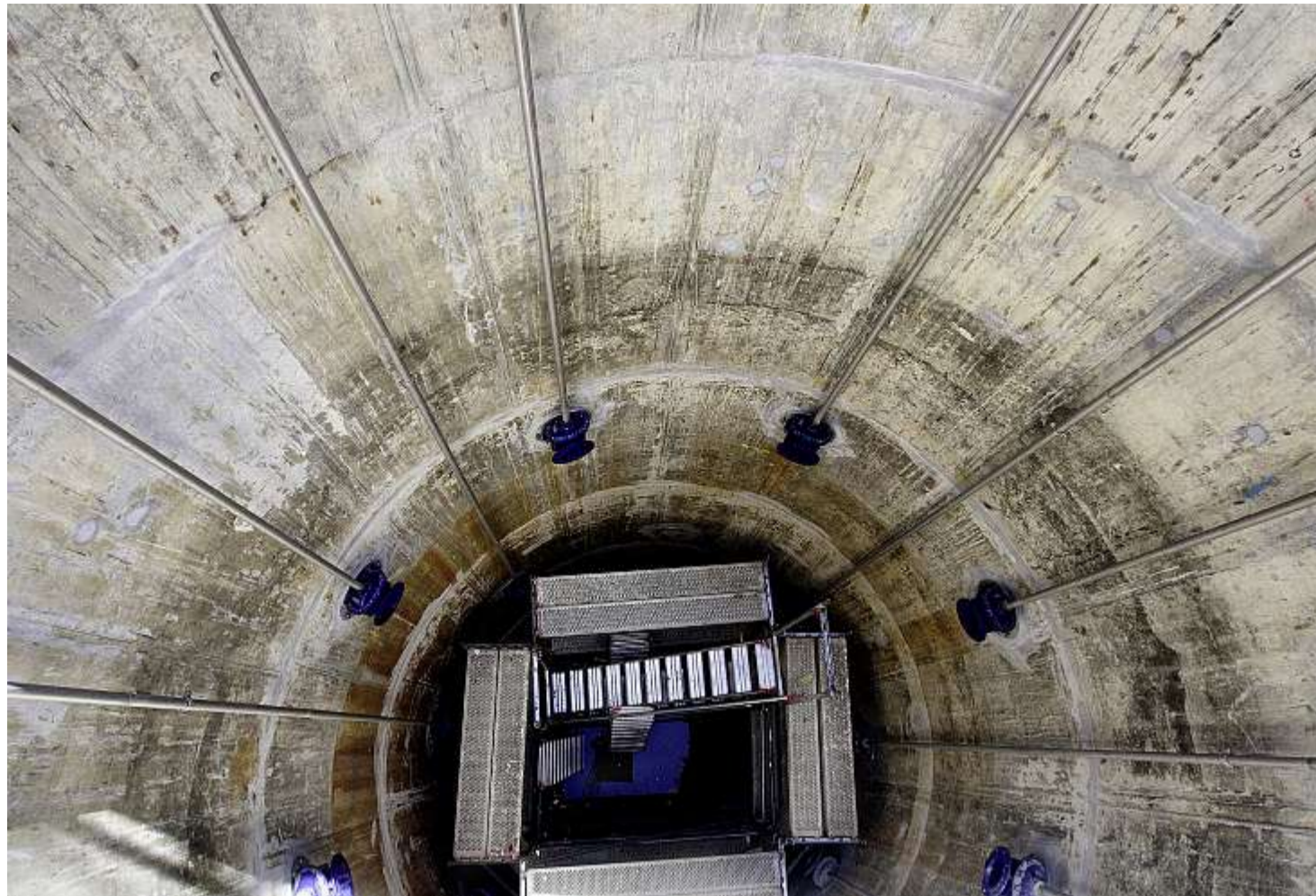
Aus den blauen Rohren wird schon bald Trinkwasser in den Brunnenschacht des Trinkwasserpumpwerks im Amerika-Egge in Uetendorf schiessen.
