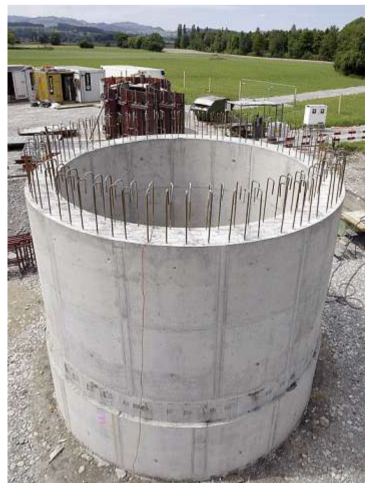
Der Brunnen für das neue Trinkwasserpumpwerk in Uetendorf wird dereinst 25 Meter tief in den Boden reichen.
